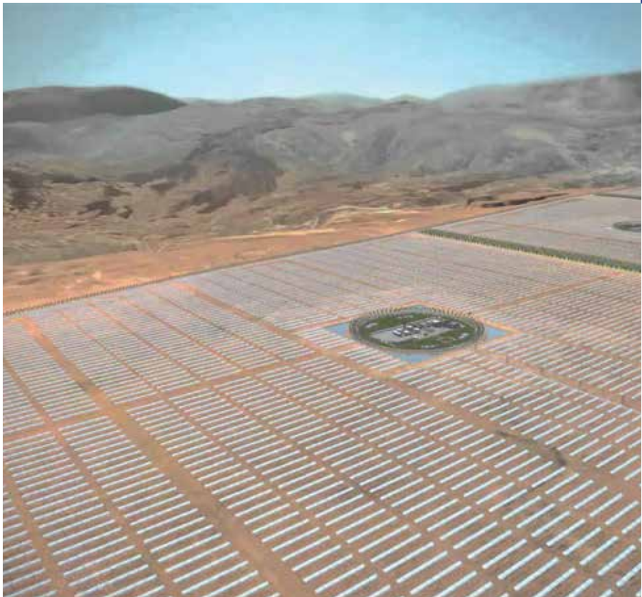
Centrale solaire Nour I - Ouarzazate
