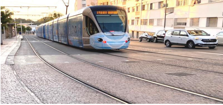
Figure 68 : Pavage de la voie de tramway* à Rabat en marbre gris-rosé de l'Oued Akrech.
