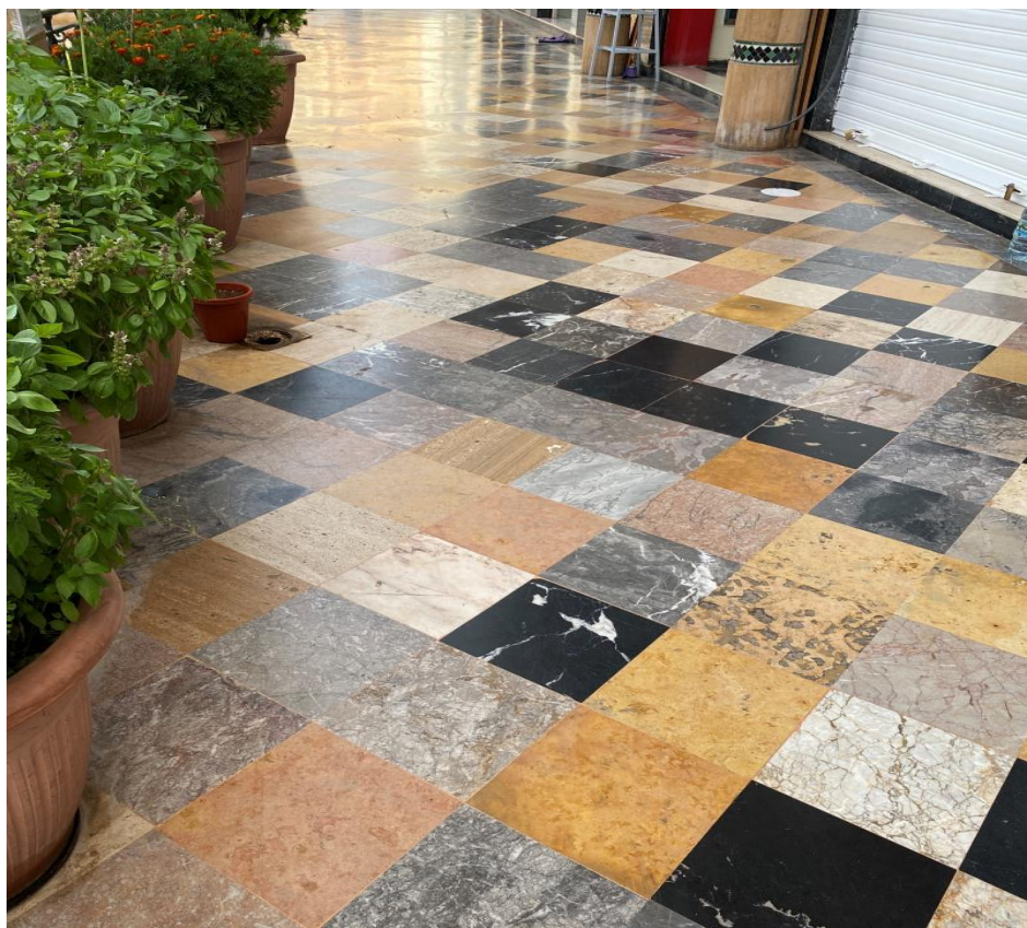
Figure 108 : Revêtement du sol dans un centre commercial à Rabat en carreaux de marbres marocains de couleurs et de textures variées.
