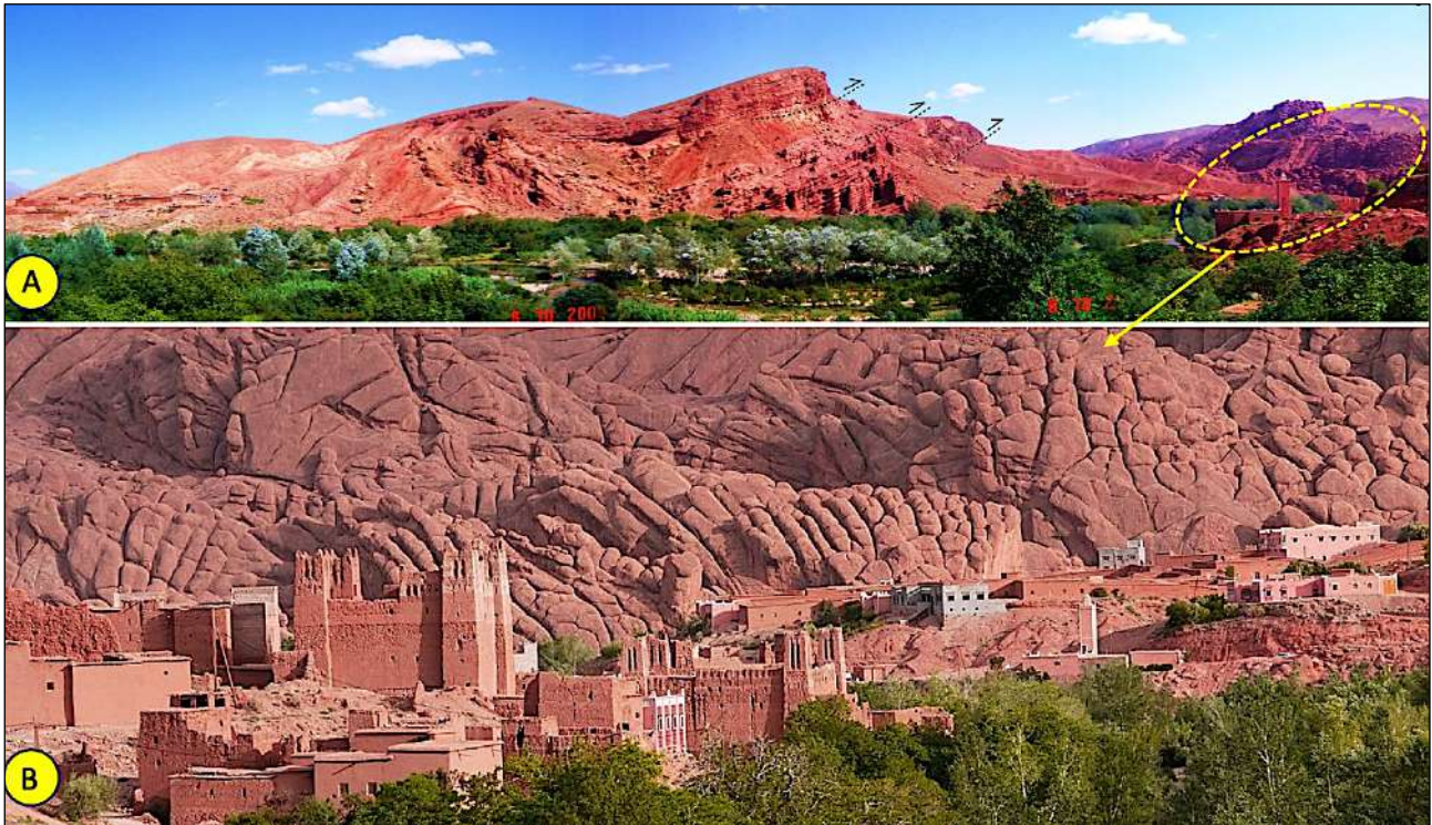
Figure 20 (ex. 36) : La vallée du Dadès. A – Vue vers l'est de la vallée montrant des chevauchements tectoniques où les formations carbonatées jurassiques surmontent les formations détritiques tertiaires. B – Détail des formations détritiques tertiaires affectées par une érosion guidée par un réseau de diaclases orthogonales. Les formes spectaculaires ainsi dégagées sont connues dans le secteur touristique sous le nom de « Doigts de Singe ».
